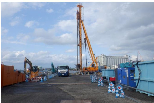
新潟港東港区南埠頭（直轄工事）
