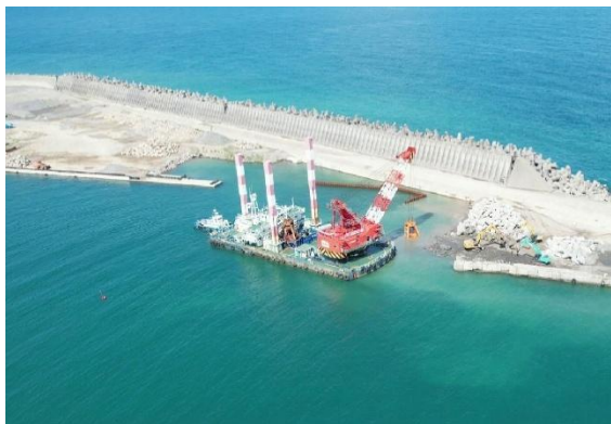
姫川港西埠頭（県工事）
