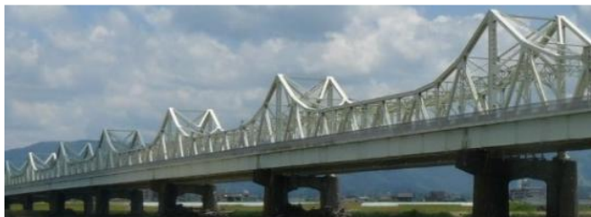
長生橋(一般国道351号)
