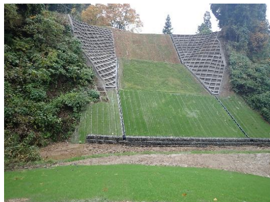
治山施設災害復旧事業 【小千谷市】
