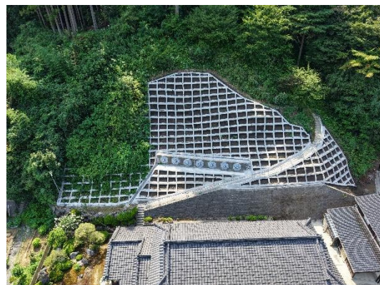
緊急機能強化・老朽化対策事業 【柏崎市】
