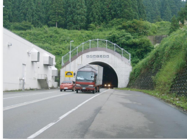
主要地方道十日町当間塩沢線 大沢山トンネル（十日町市～南魚沼市）
