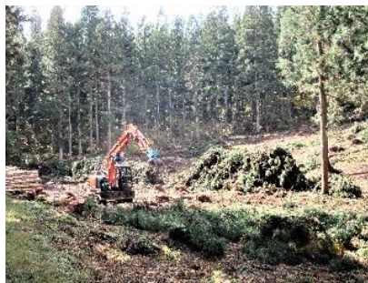
主伐と同時に地拵えを実施
