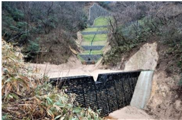
治山事業による山地災害からの復旧（村上市）
