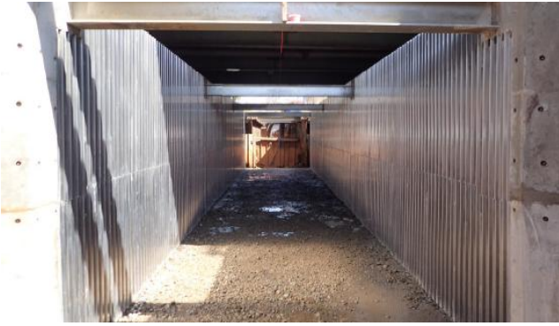
佐印川排水路地区 【株中央建設】
