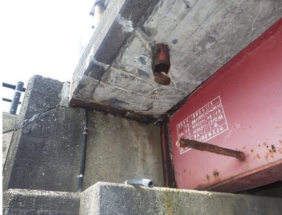
鋼材の当て板補修、床版の補修、 排水管の補修
