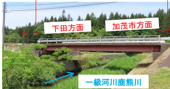
岩谷橋 橋長 L=20.0m
