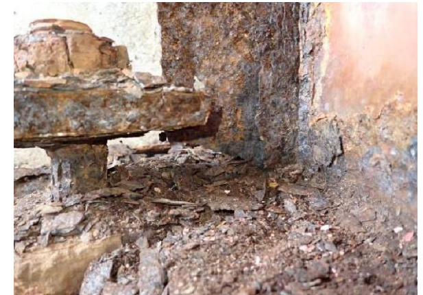
支承の補修、鋼材の当て板補修
