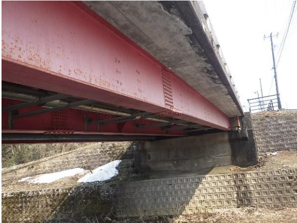
鋼桁の再塗装
