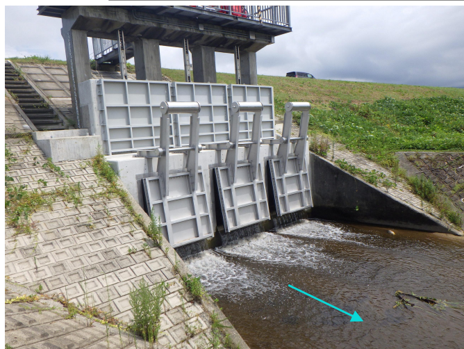
①高田排水樋管（吐口側）
