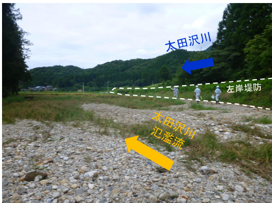
太田沢川氾濫痕跡(写真①)
