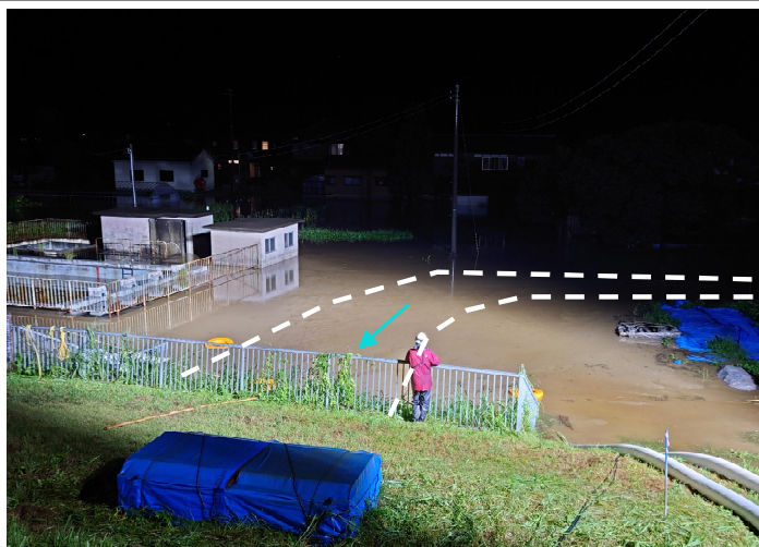
②高田排水樋管（呑口側） (R4.8洪水時)
