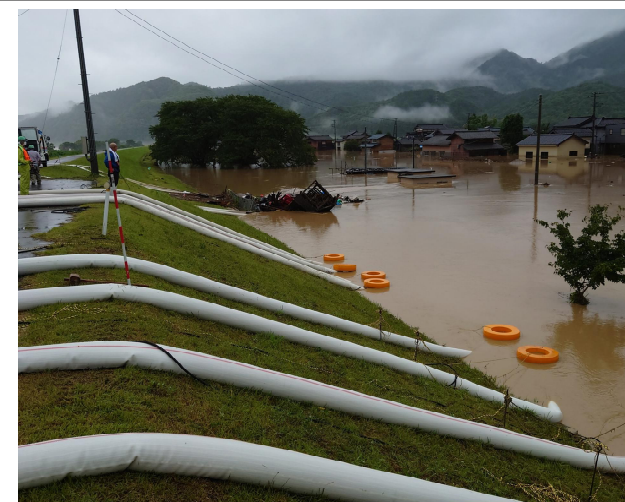
③排水ポンプ車稼働状況 (R4.8洪水時)
