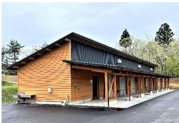
県産木材を利用したバーベキュー施設（上越市）
