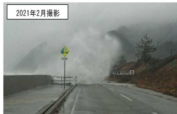
風浪による越波状況
