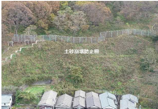
寢屋集落と背後の土砂崩壊防止柵
