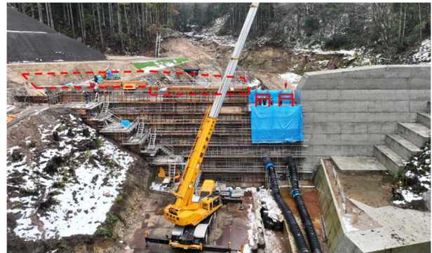
既設砂防堰堤の嵩上げ（小岩内大沢川）
