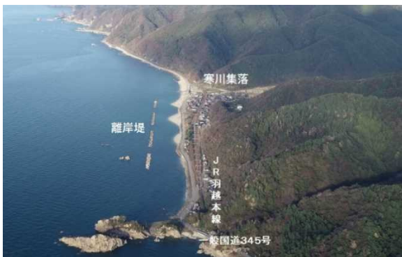
寒川地区海岸の侵食対策
