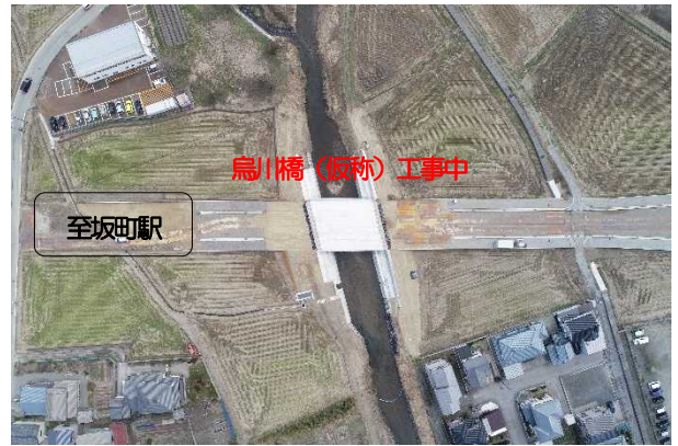
東大通り線整備状況「仮称 烏川橋」
