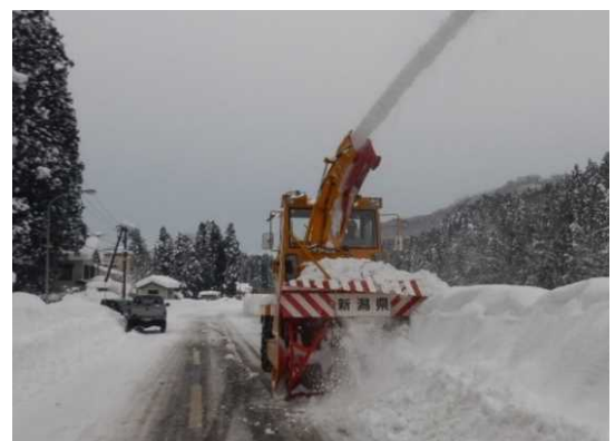
早朝の県道除雪作業
