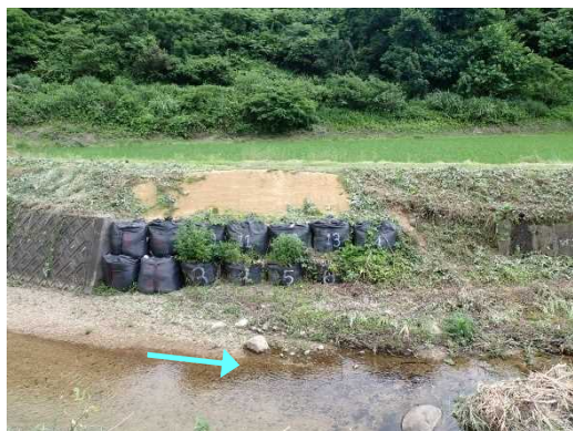
大川（柏尾）護岸工事前
