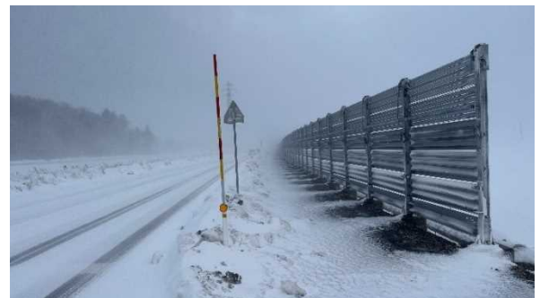
地吹雪防止柵による視距の確保（村上市山屋）
