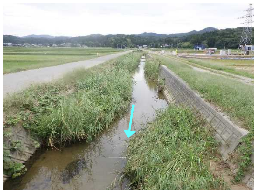
堀川 河道掘削前
