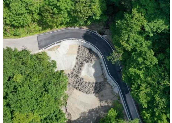
復旧工事完了
