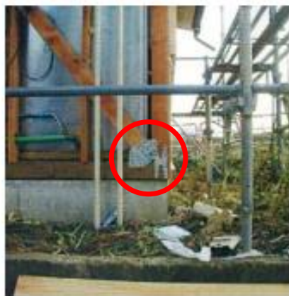
柱端部の金物補強
