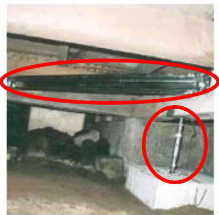
床下の金物補強
