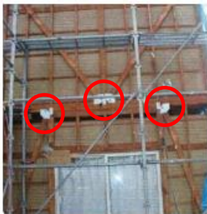
筋交い端部の金物補強
