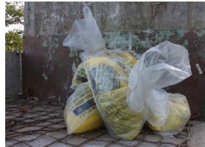
混入した保温材（二重袋×5個）分けて保管していたが、収集業者にまとめて渡してしまった。
