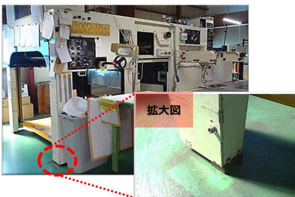
位置ズレによる機械設備の不調
