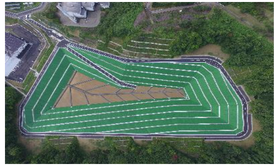
エコパークいずもぎ第3期処分場
