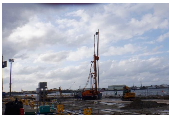
新潟港東港区南埠頭 直轄工事
