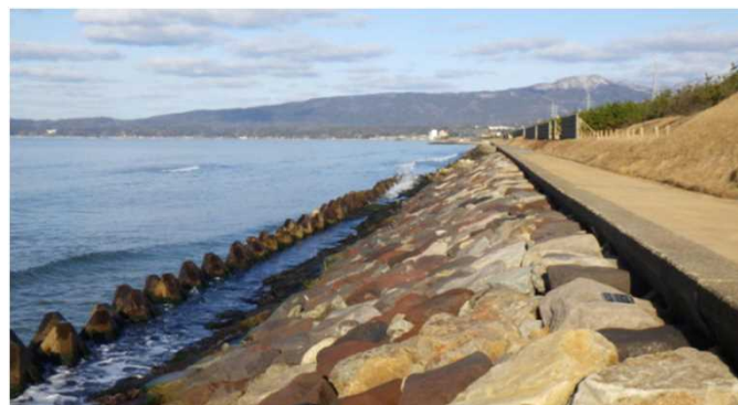
工事名 離島漁場保全の森（防災林造成）工事（離漁場（海）第1-1号） 施工地 佐渡市八幡 施工者 澤根・渡辺建設経常共同企業体
