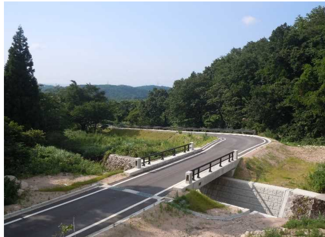
工事名 県営林道開設・基幹道 五頭山麓南線下山工区2 開設工事 施工地 阿賀野市保田 施工者 (株)坂詰組
