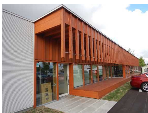
県産木材を外構に利用したコワーキングスペース(燕市)
