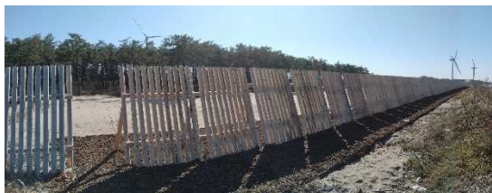
公共土木工事で施工された防風柵
