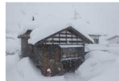
旧室岡家住宅 [十日町市] (十日町市ホームページ)
