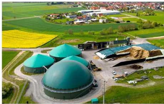
Großbardorfのバイオガスプラント 出典 Main-Post GmbH オンライン記事（2022.5）
