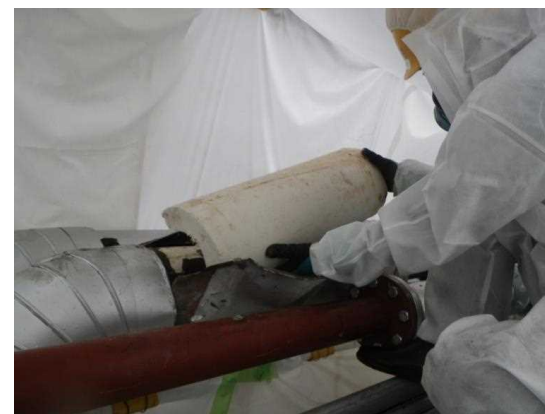
養生内で湿潤化後、手作業で除去
