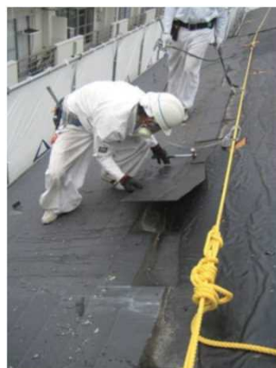
スレートの除去
