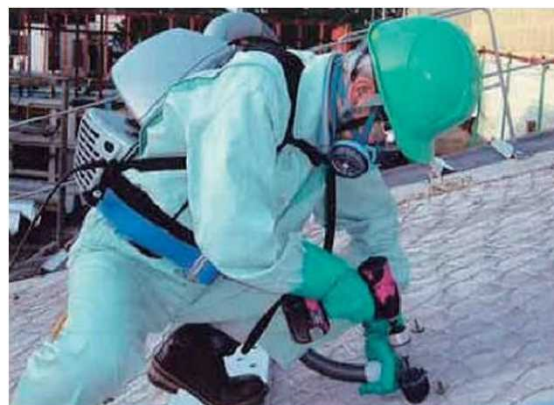
集じん回収（高性能真空掃除機）
