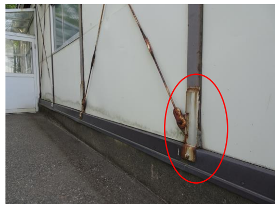
◀ 洗濯室外部柱の補強状況 ▶
