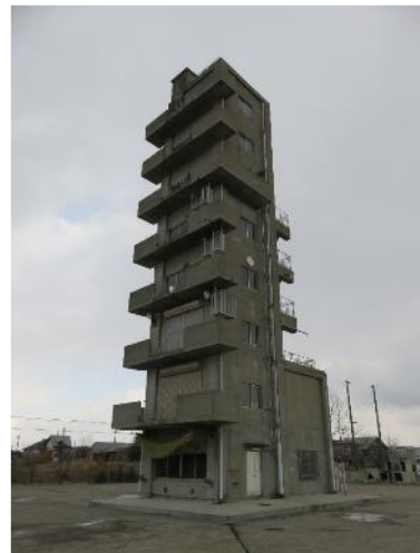
主塔 S58.3 竣工
