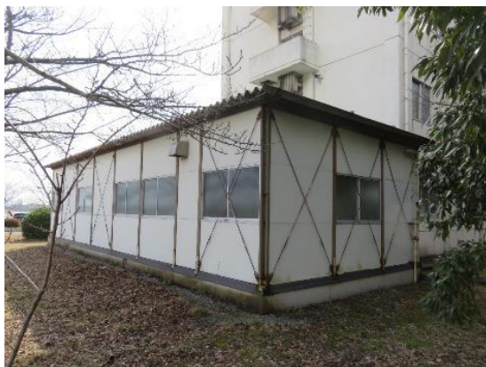
◀ 洗濯室外観（曾水寮脇） ▶
