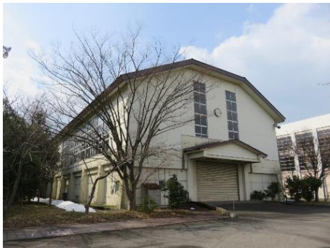
《屋内訓練場外観》
