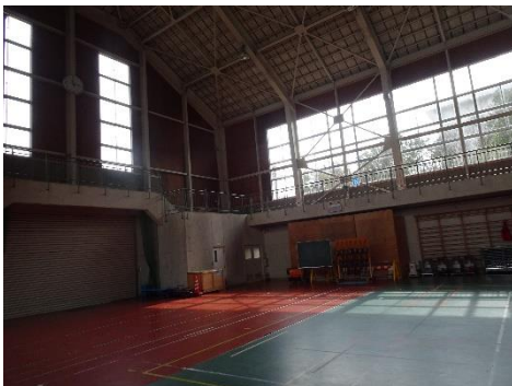
《屋内訓練場内部》
