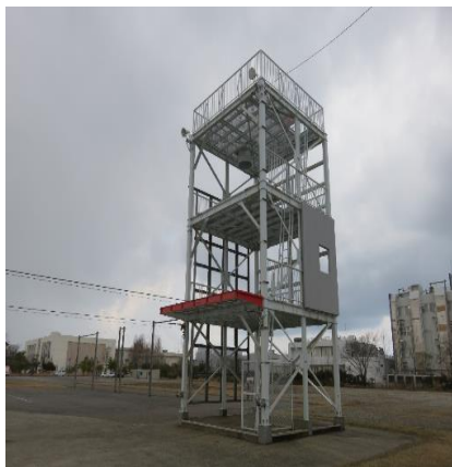
副塔 S58.3 竣工
