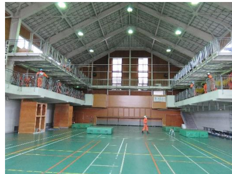
《屋内訓練場内部》
