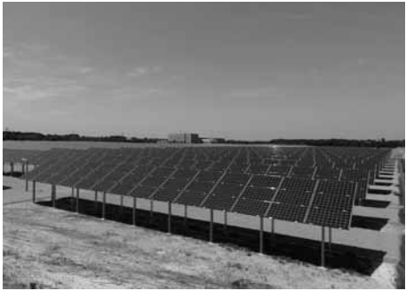
新潟東部太陽光発電所(2号系列)
