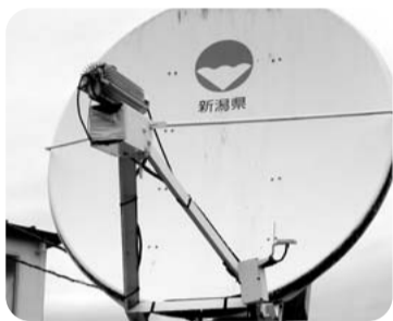
防災無線に使用する衛星系アンテナ
