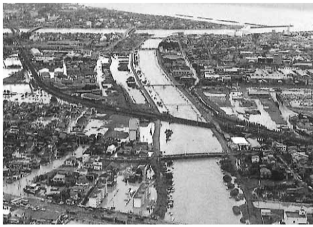
平成7年7月豪雨による保倉川の状況
