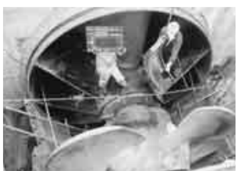
新川河口排水機場主ポンプ分解点検整備工事
