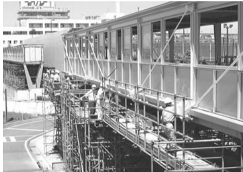
残存デッキの調査
