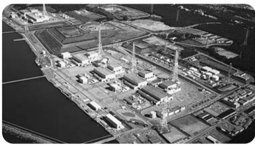
柏崎刈羽原子力発電所
