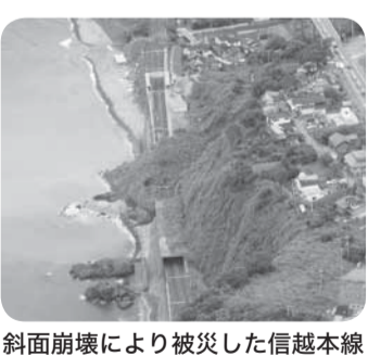
路肩が崩壊した県道(柏崎市)
