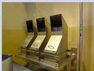
静的触媒式水素再結合装置(PAR)
