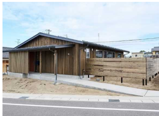
県産木材を外壁に利用した住宅
