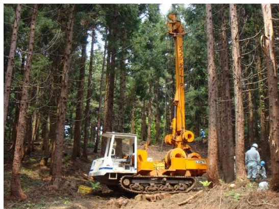
タワーヤード
