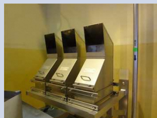
静的触媒式水素再結合装置(PAR)
