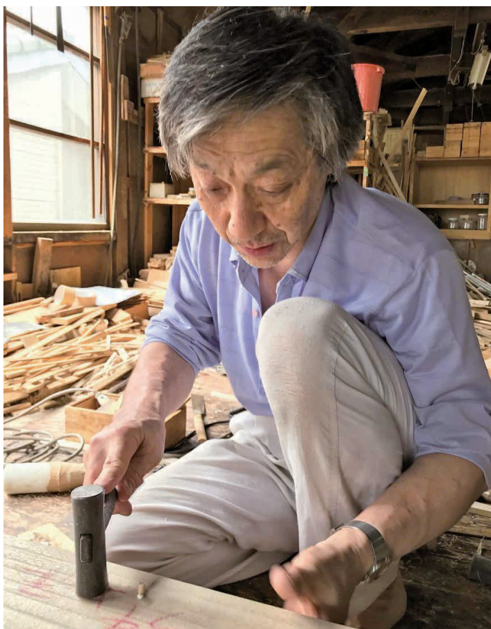
〔切り組み作業〕木釘を用い、天板に仕切り束（つか）を接合する作業の様子
