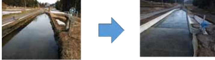
<用水路の表面被覆工法による補修>
