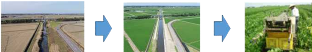
<湛水被害防止のための排水路整備> (改修前) (改修後)
