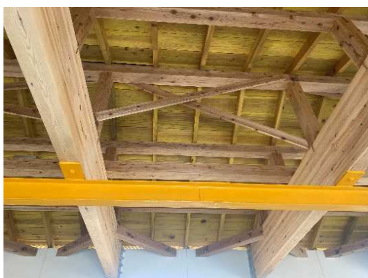
県産木材を構造部に利用した揚水機場上屋
