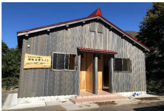
県産木材を使用して建築した観光施設 (登山道トイレ)
