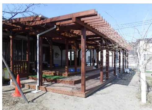
県産木材を利用した保育施設 (ウッドデッキ)
