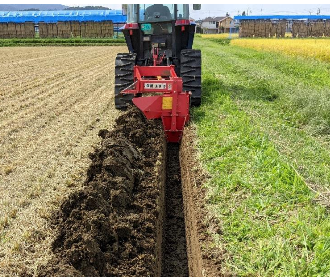
○周囲明きよの施工の様子
