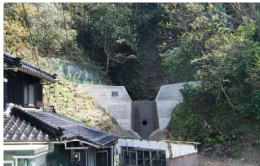
<河川上流域における治山施設の整備>
