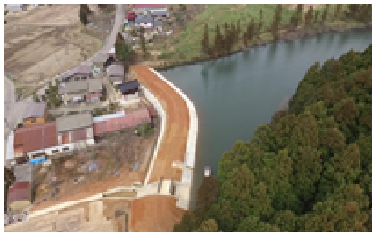
<ため池における対策工事の実施>
