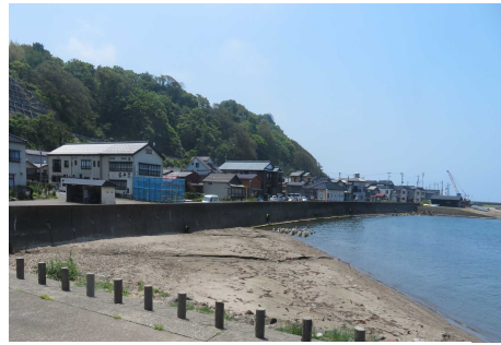
＜背後集落等を守る海岸保全施設＞
