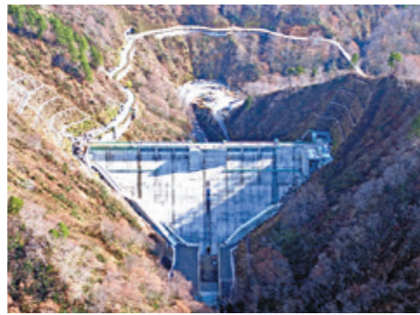
建設中の奥胎内ダム(平成28年11月)
