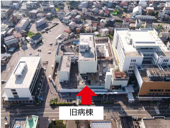
▲令和3年6月（解体前）
