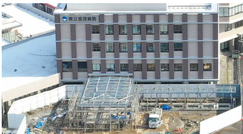
▲キャノピー・結モール建設現場（R4.1.25時点）
