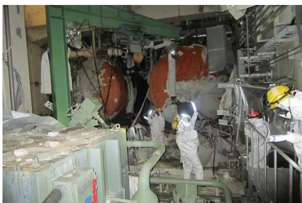
1号機原子炉建屋4階
