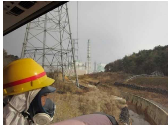
夜ノ森線鉄塔倒壊現場
