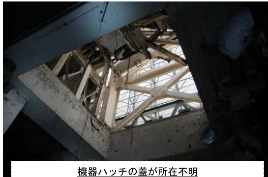
機器ハッチの蓋が所在不明 委員意見：4階で水素が漏洩して爆発したことを示唆しているのではないかと。 東電説明：解析結果から上へ飛ぶ可能性も下に落ちる可能性もある。爆発箇所を特定する根拠にならない。
