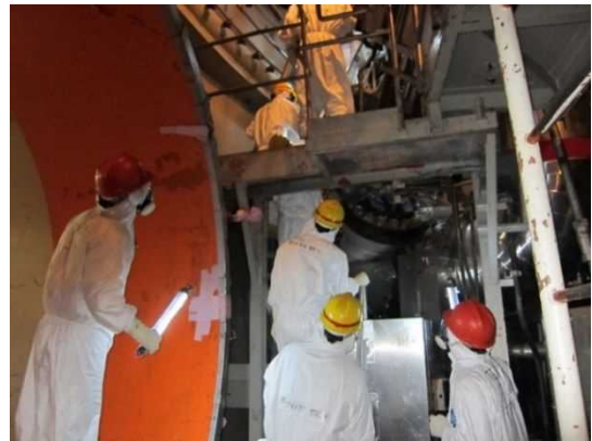
5号機格納容器内
