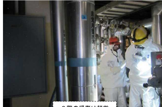
3階の損傷は軽微
