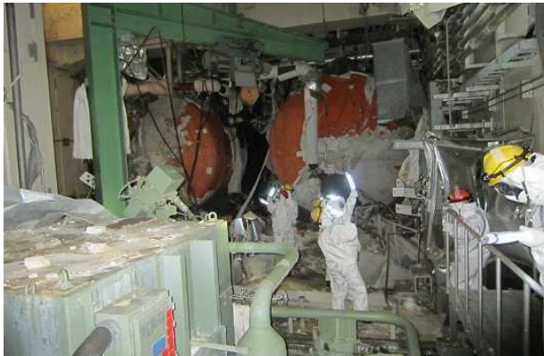
福島第一原発 1号機原子炉建屋の現地調査
