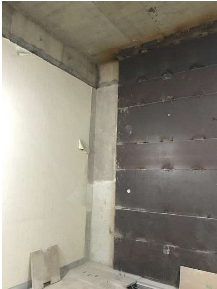
▲放射線が外にでないようにするため遮蔽鉄板を壁に埋め込む工事です。
