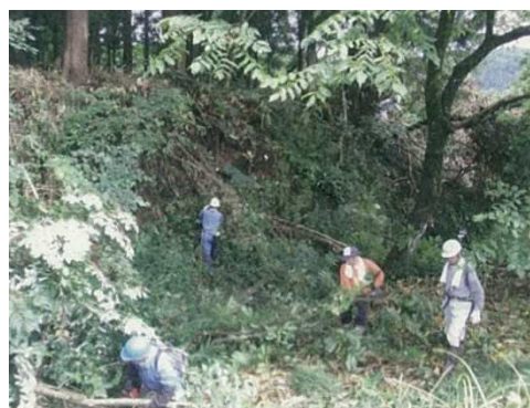
緩衝帯整備実施状況
