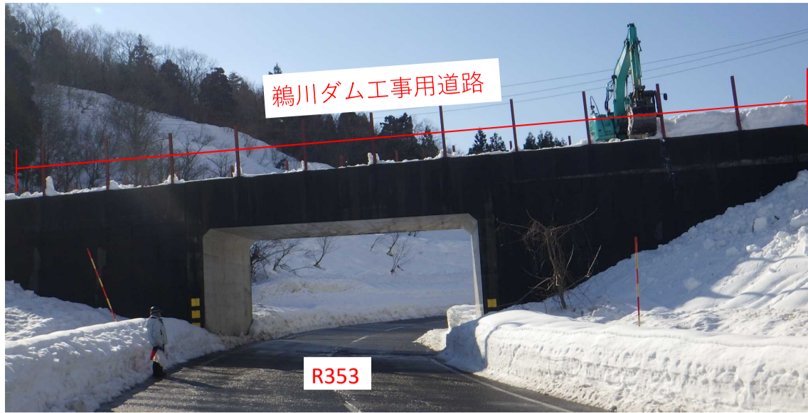
④工事用道路除雪状況
