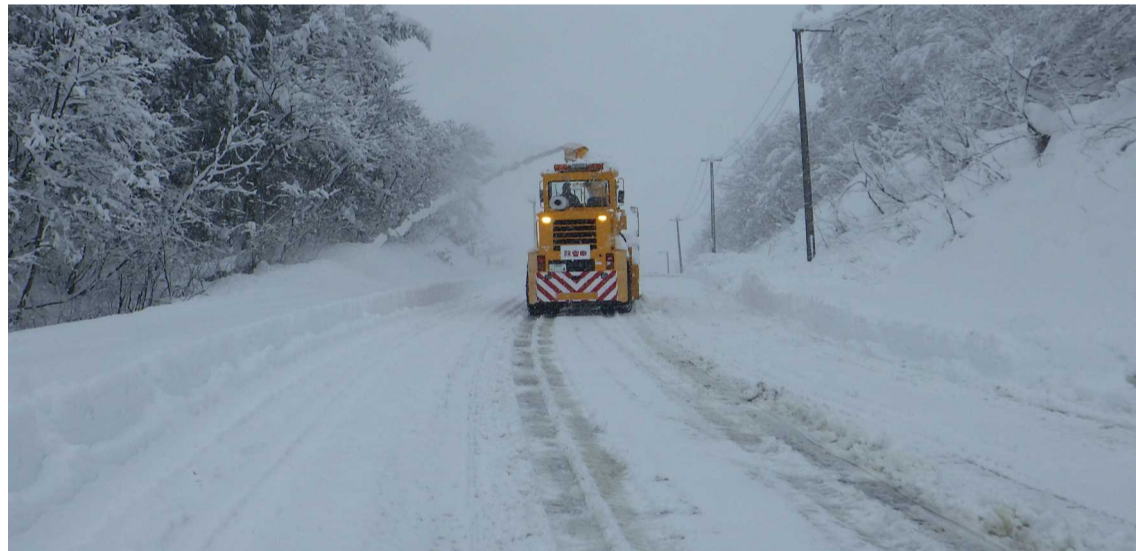
⑥工事用道路除雪状況
