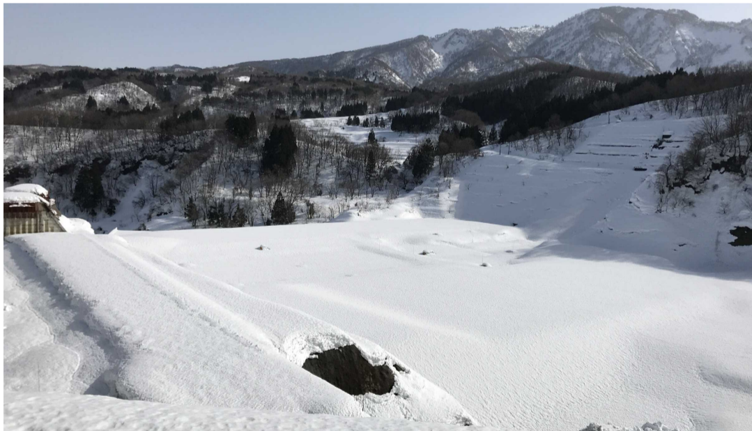
ダムサイト 上流から下流を望む(R3年1月中旬撮影)
