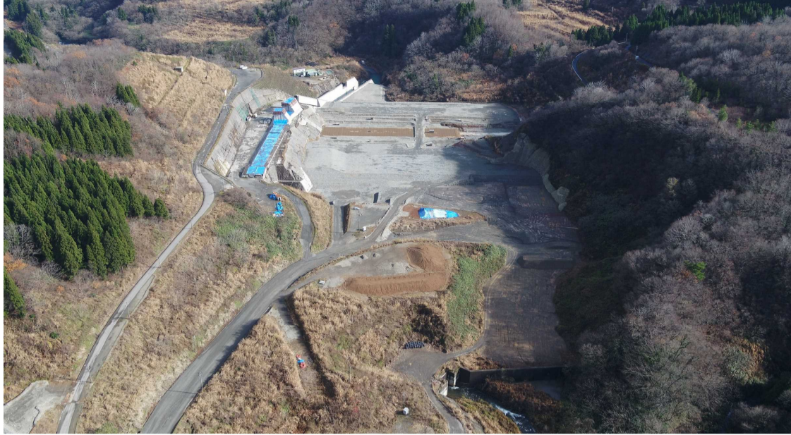
ダムサイト 上流から下流を望む(R2年12月上旬撮影)
