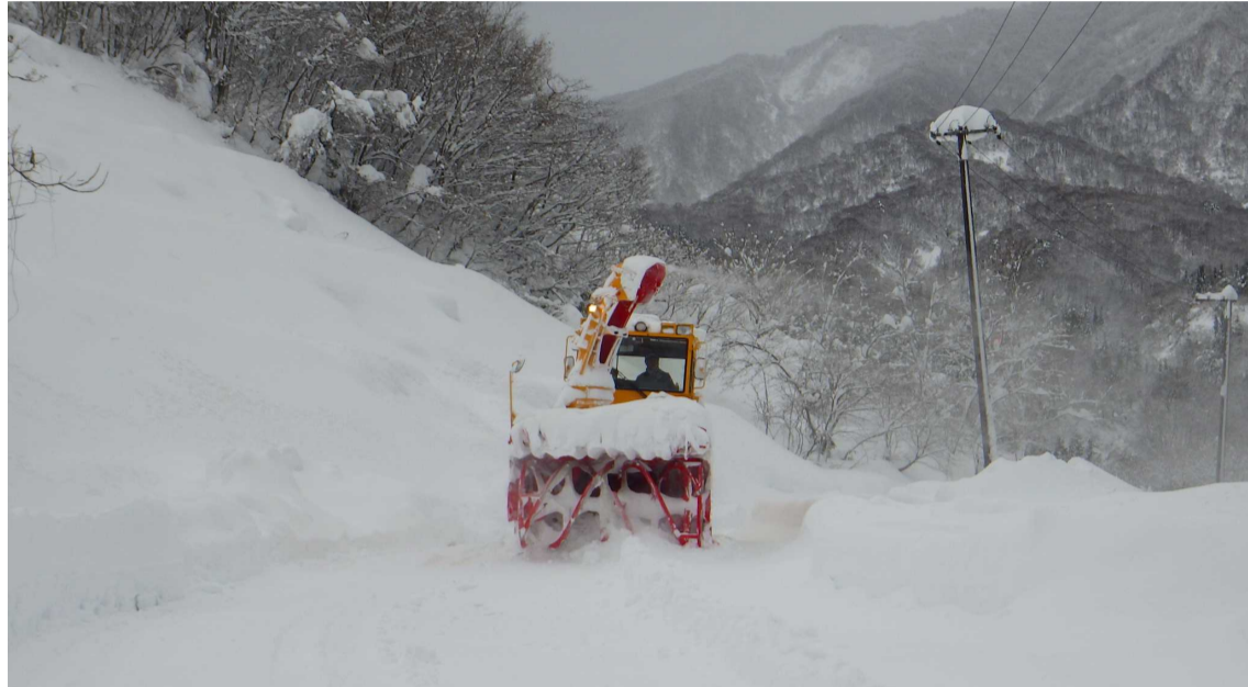
⑤工事用道路除雪状況
