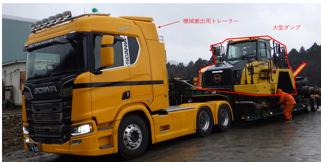
③大型ダンプ搬出状況
