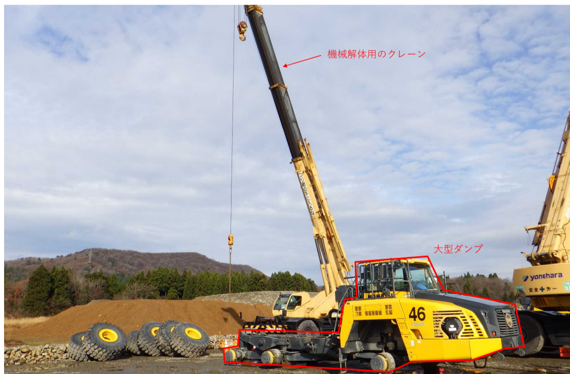
②大型ダンプ解体状況
