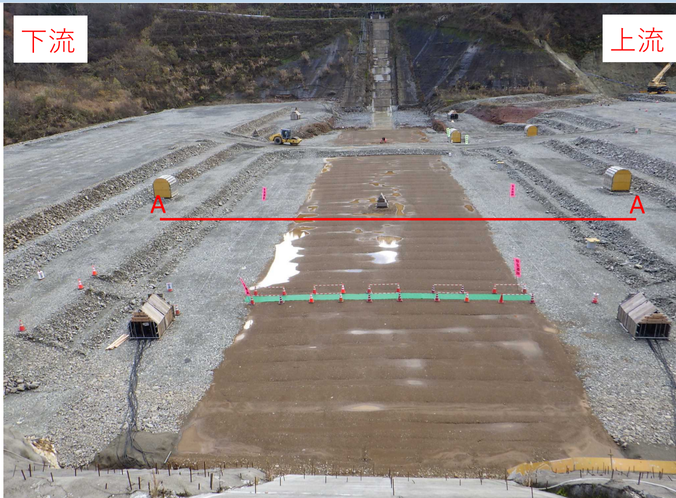
左岸から堤体河床部を望む
