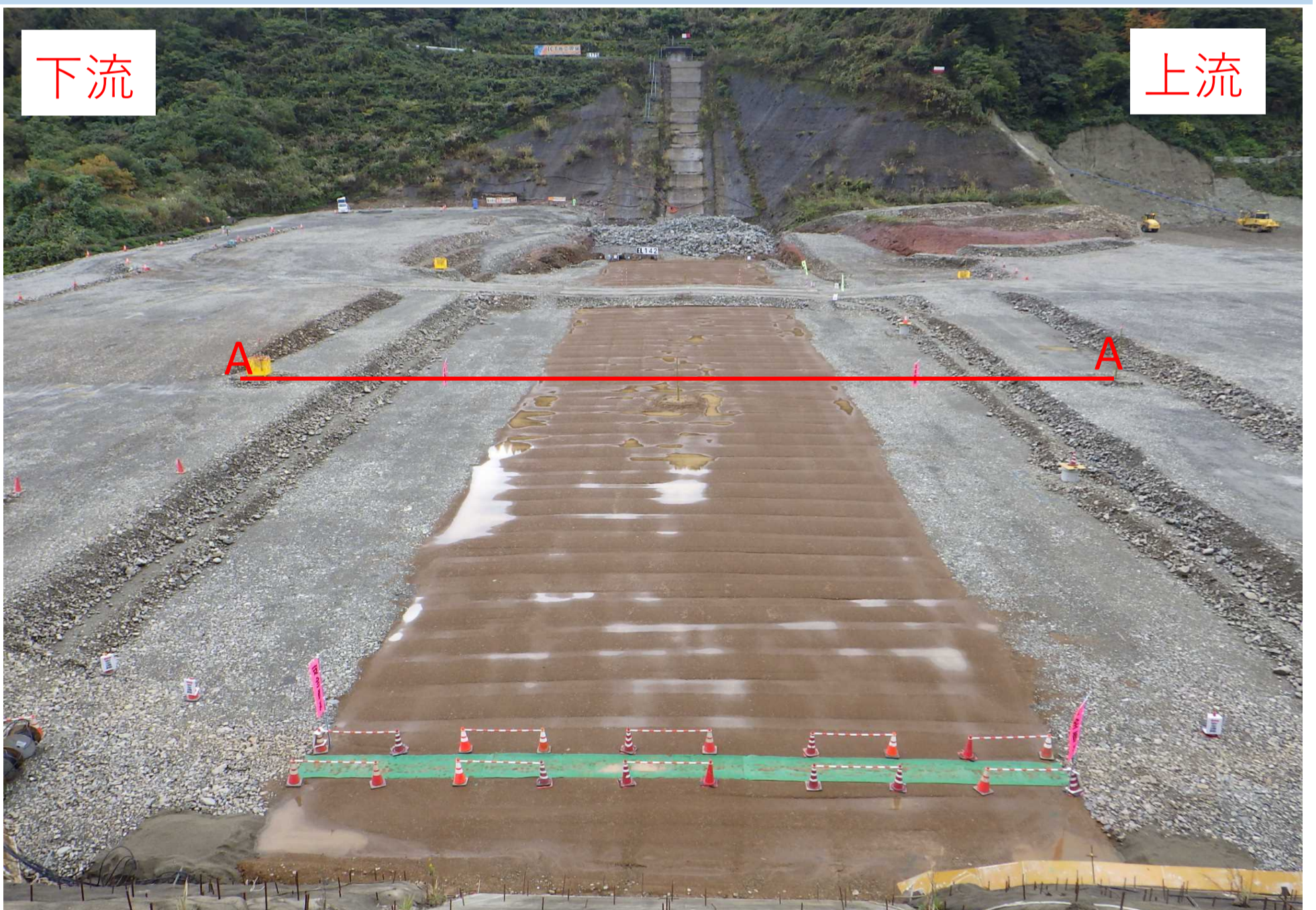
左岸から堤体河床部を望む
