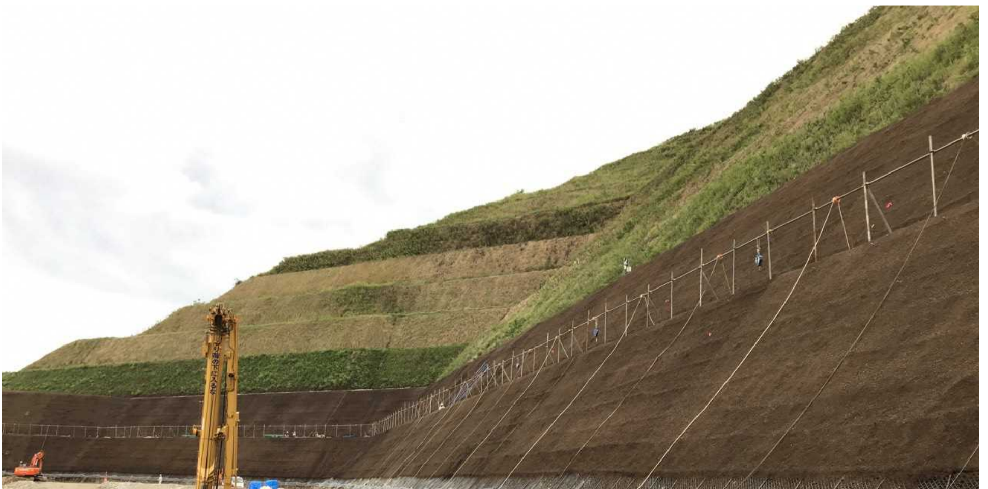
植生基材吹き付け完了
