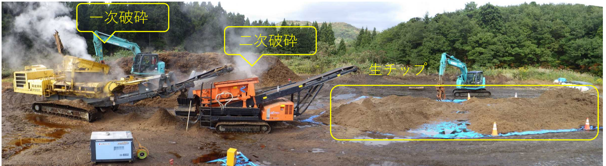
伐採木の破碎状況
