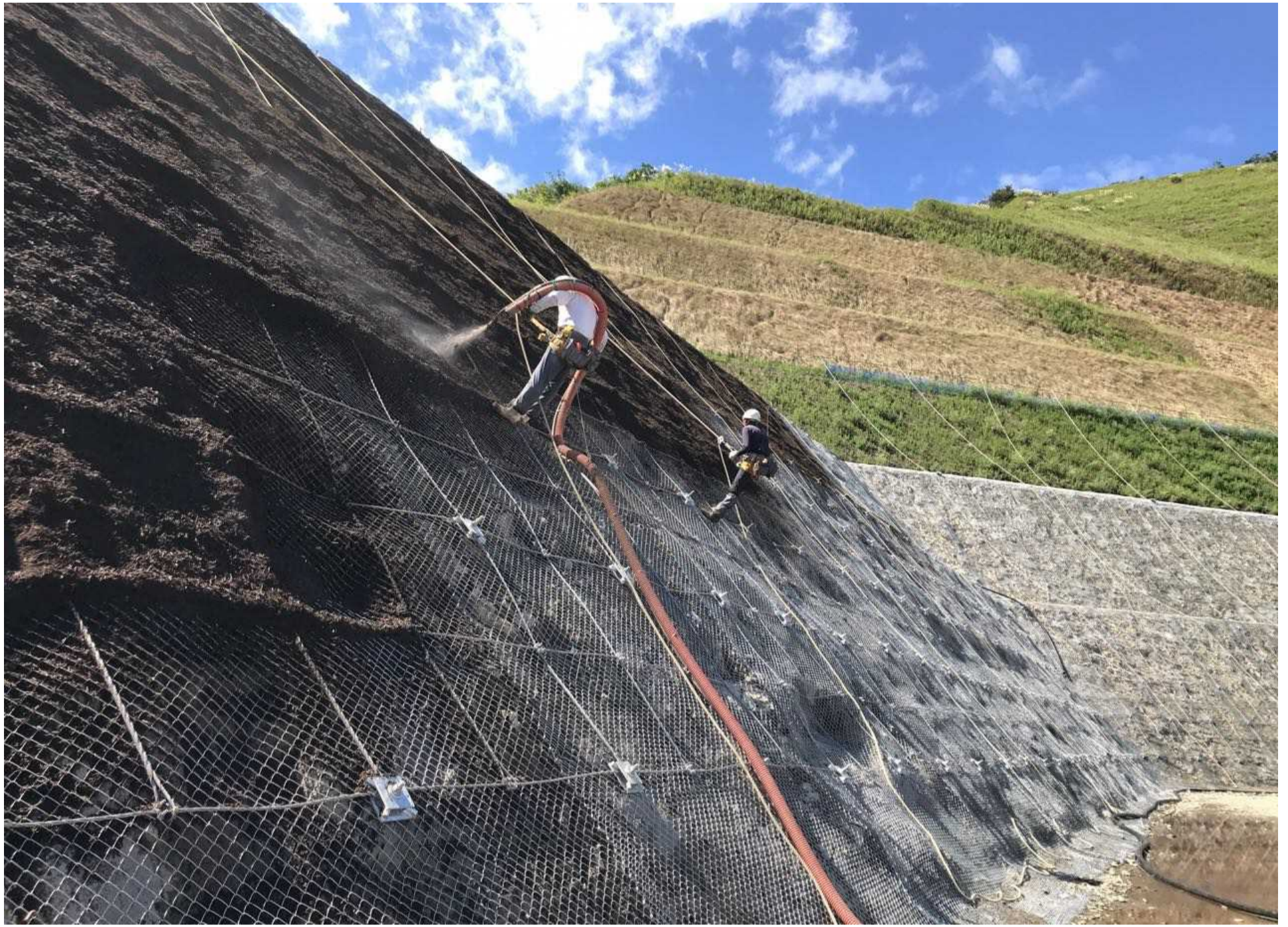
植生基材吹き付け状況
