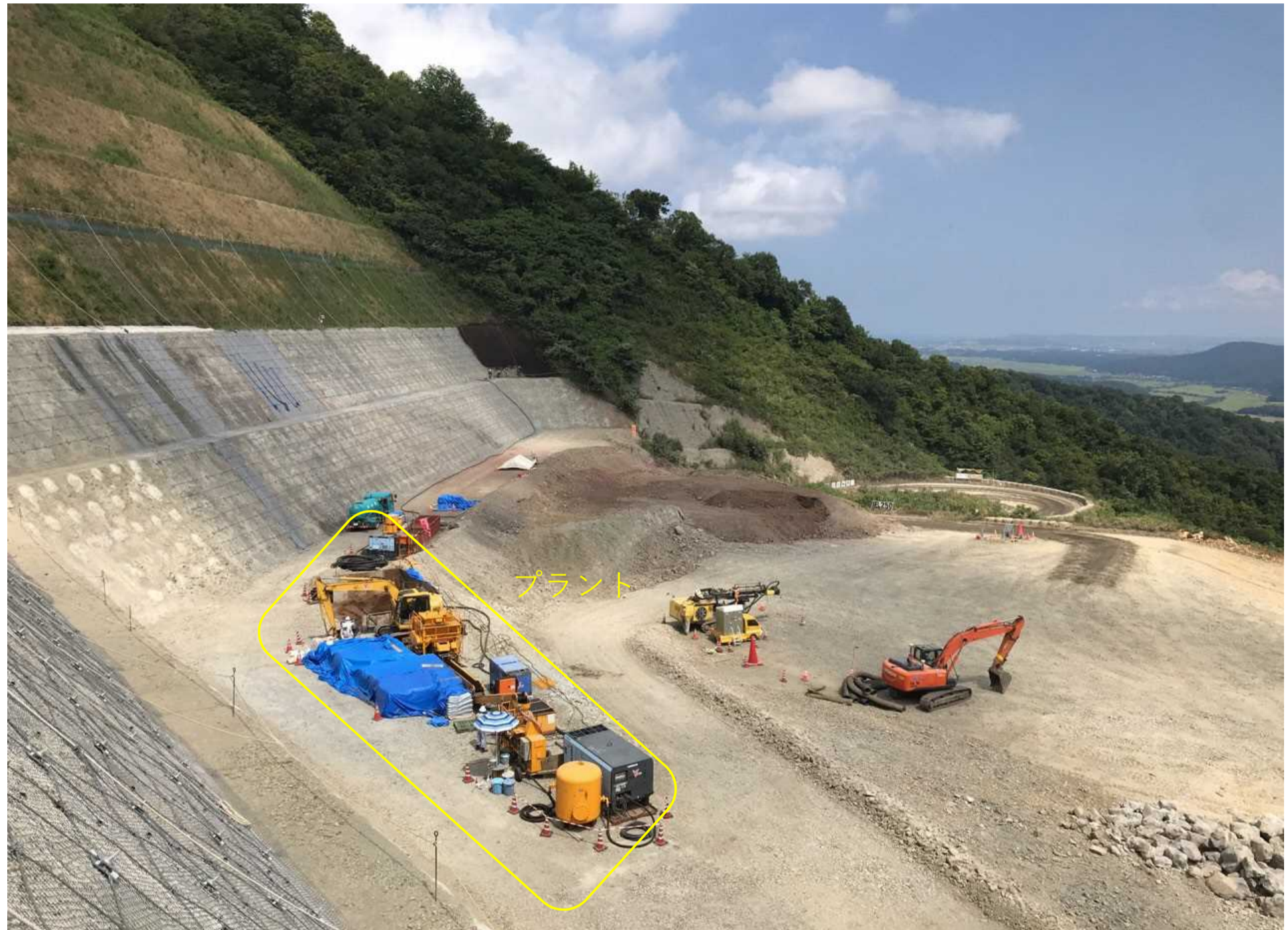
プラント設置状況
