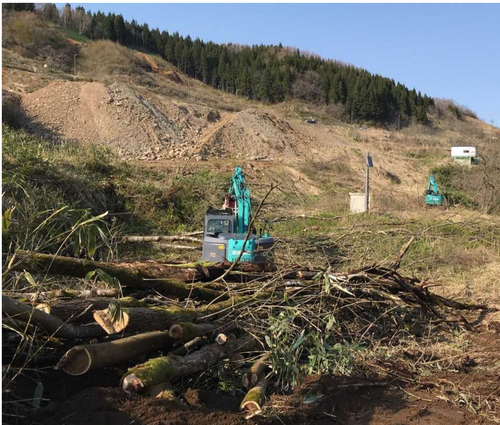
貯水池内の伐採状況
