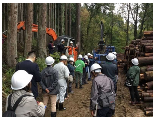
県産木材の生産・加工から利用までマスメディアに取材してもらうツアー ①(木材の伐採、搬出現場)
