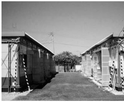
中越沖地震被災者のための応急仮設住宅
