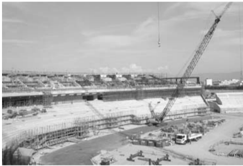
県立野球場(仮称)建設の様子
