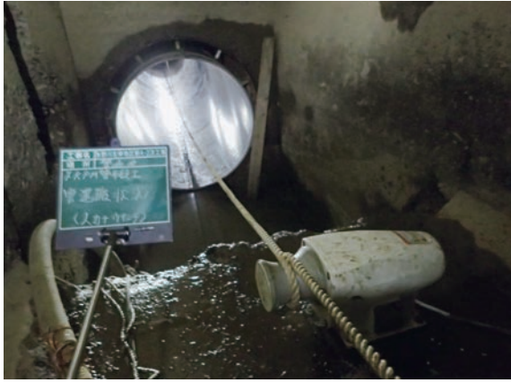
(写真3) ウィンチ設置状況
