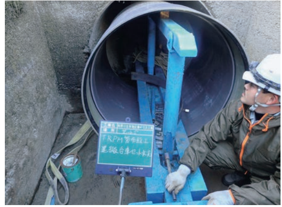
(写真4) カゴ型台車による布設状況
