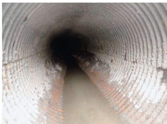
(写真1) コルゲート管内部
